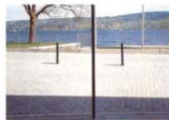
Reihenpflasterung mit Granit 7/9er
