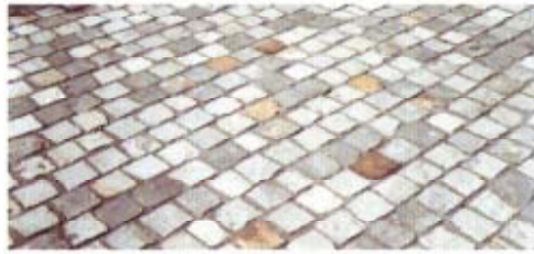
Reihenpflasterung 8/11er.
