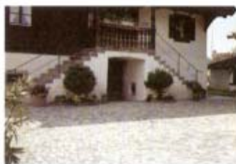
Reihenpflasterung 8/11er
